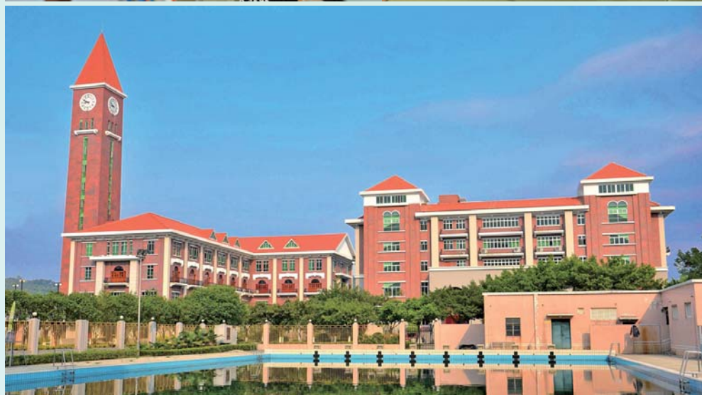
校园十大美景·姊妹楼——图书馆与综合实验楼
